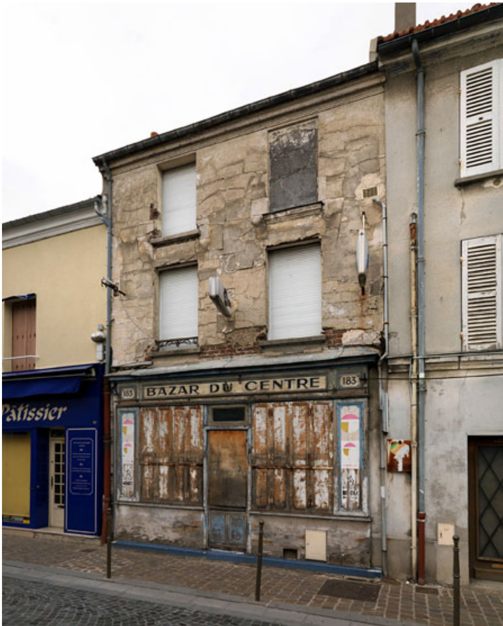
Maison à boutique à ancienne devanture du début 20e siècle, 183 rue Pierre Brossolette.
