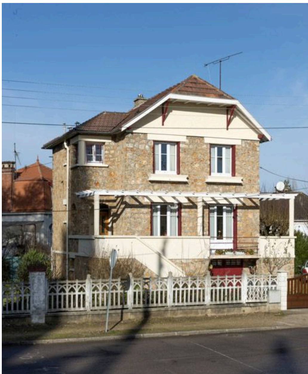
Façade de la maison.
