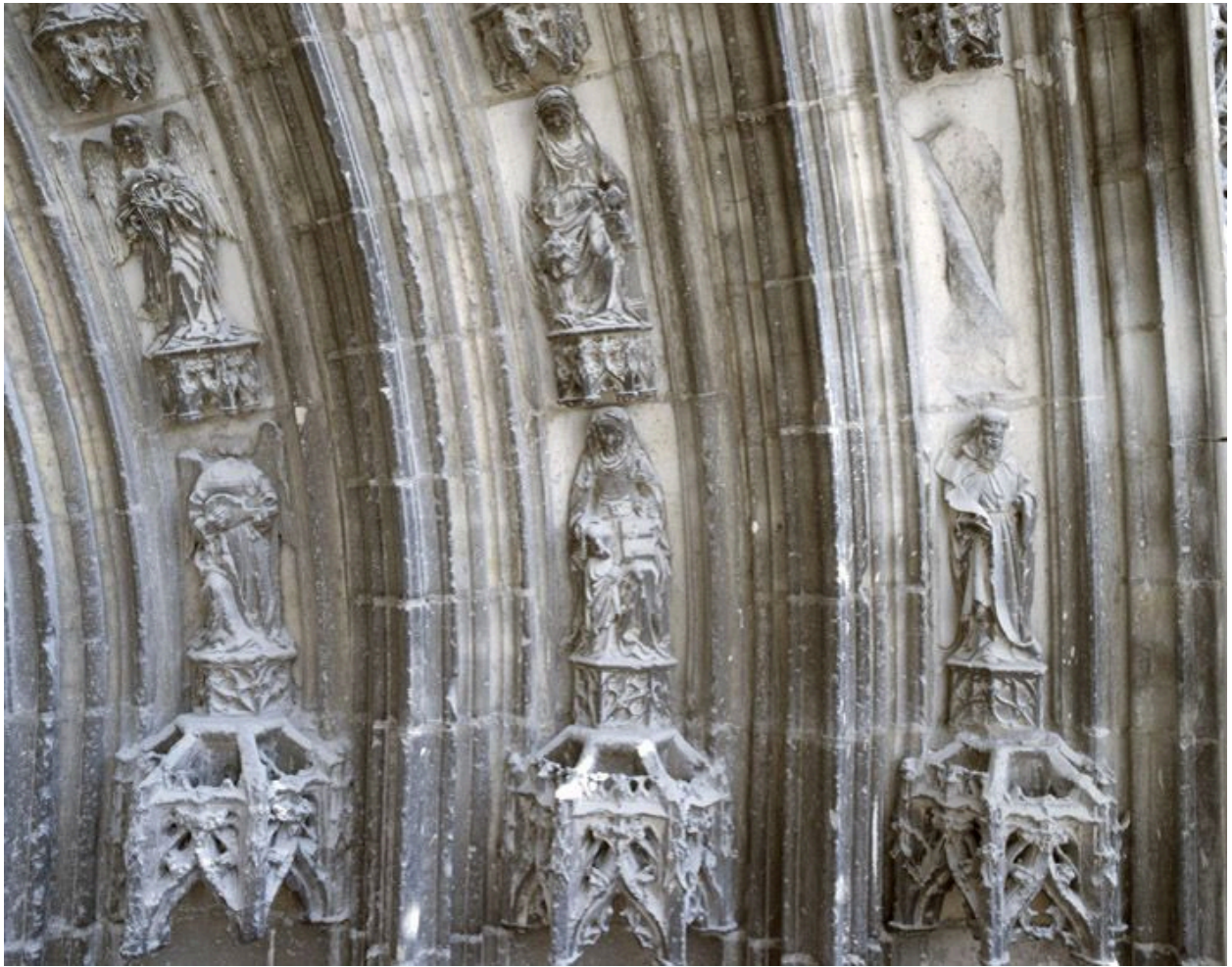
Les sculptures du portail Saint-Jean-Baptiste, vues depuis l'échafaudage dressé pour la restauration de la base de la tour nord (2008) : le départ des voussures, à droite du tympan.
