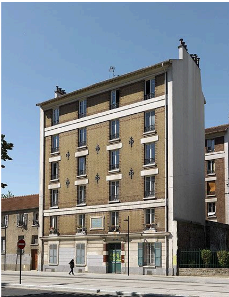
93, Saint-Denis, immeuble Le Foyer de Saint-Denis, 137 bis rue Gabriel-Péri. Elévation générale de la façade de l'immeuble sur la rue.
