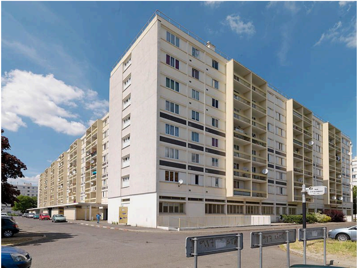
Cité dite Résidence Saint-Hubert. Façade est de la partie est du U de la résidence Saint-Hubert. Accès aux caves par des rampes.
