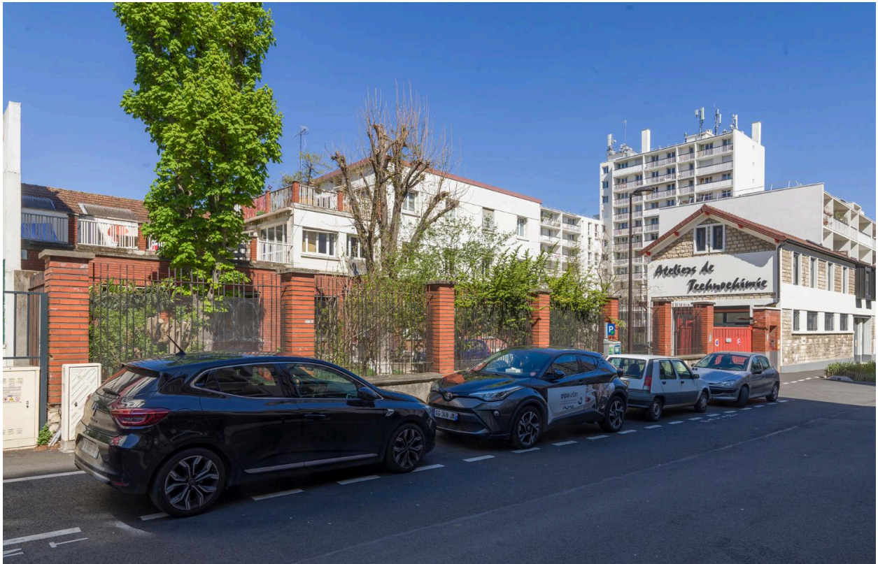
Vue extérieure des Ateliers de Technochimie, depuis la rue du Colombier.
