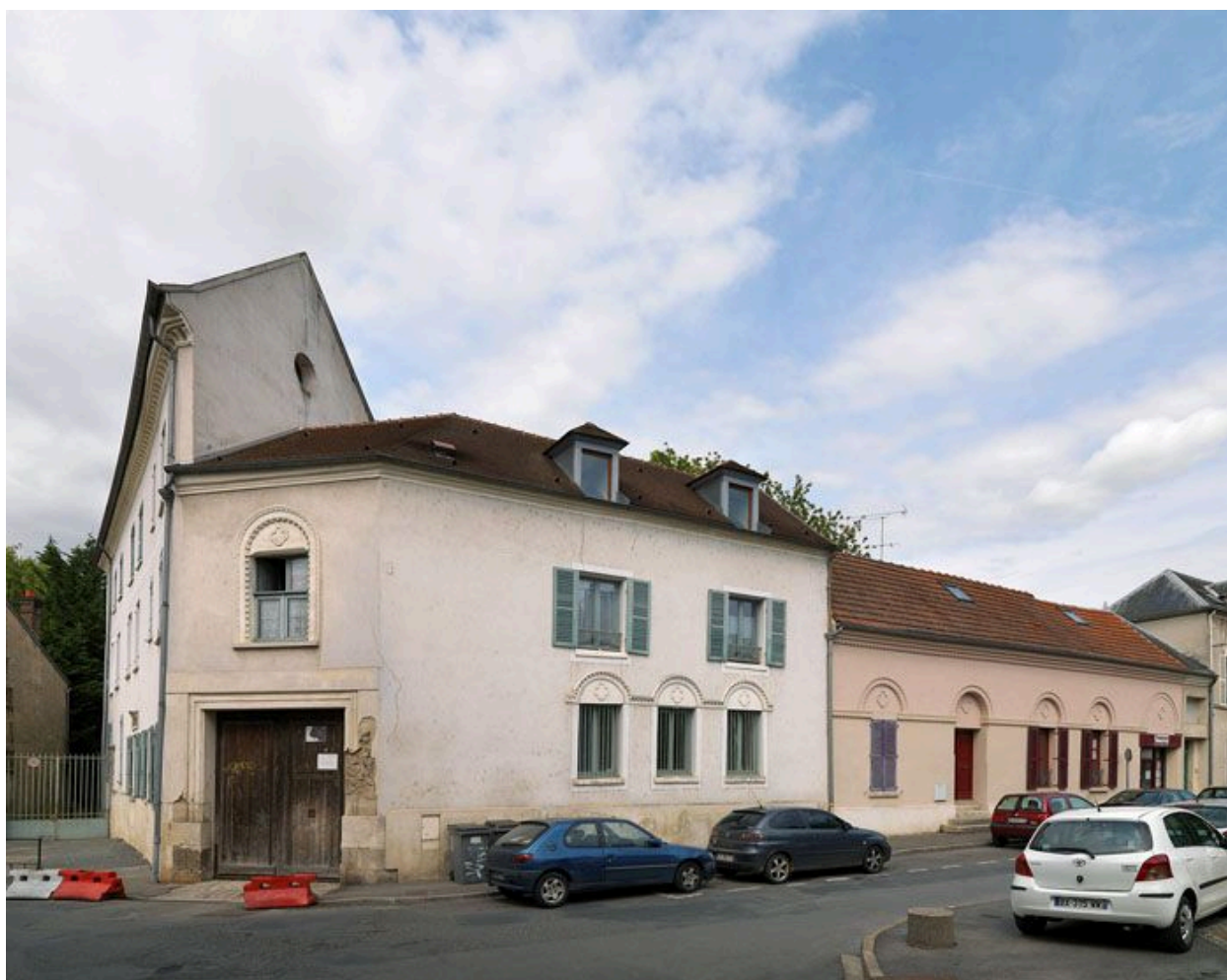
Les bâtiments longeant la rue de la Grande-Île.
