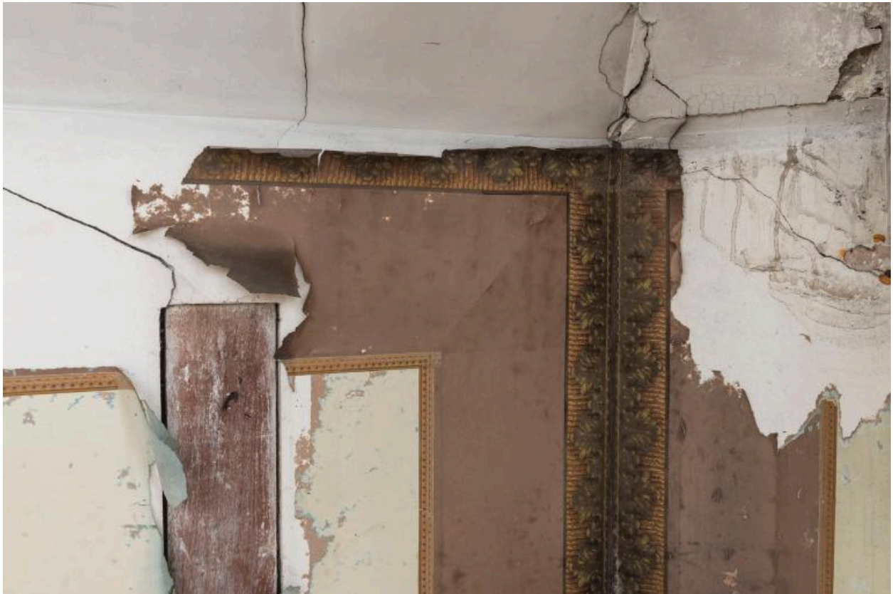
Détail de l'intérieur
