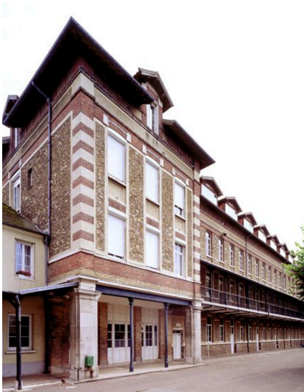
Le "Grand Quartier" : élévation postérieure, vue du nord.
