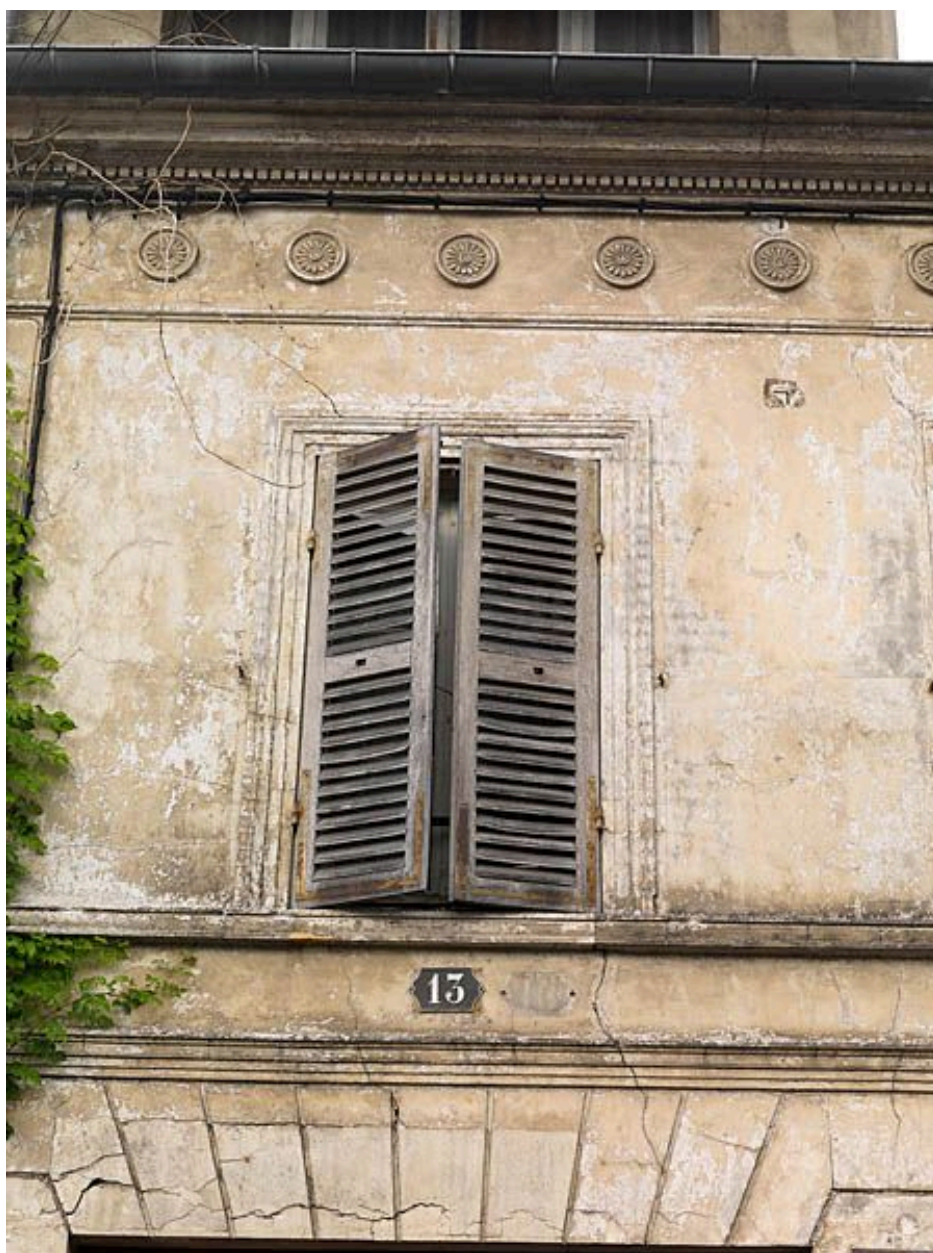
Détail du décor stucqué, sur la première travée (au-dessus du passage cocher).
