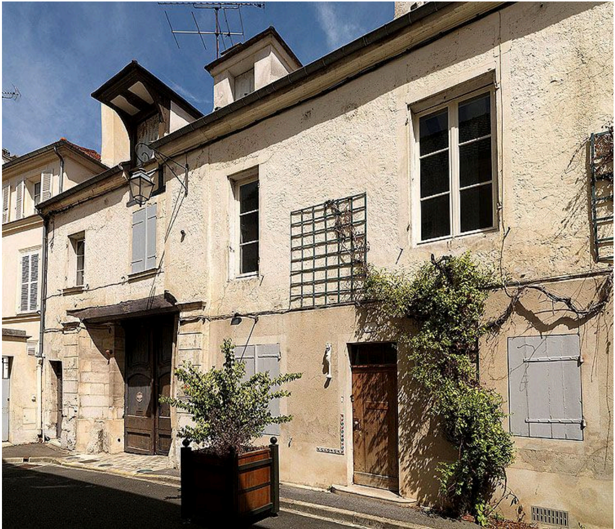
Vue générale de l'élévation sur rue.
