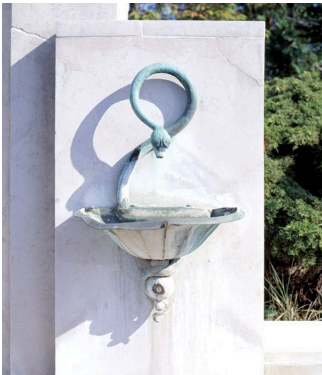
Détail du bassin : l'une des fontaines, reprenant l'emblème de la "Cooper".
