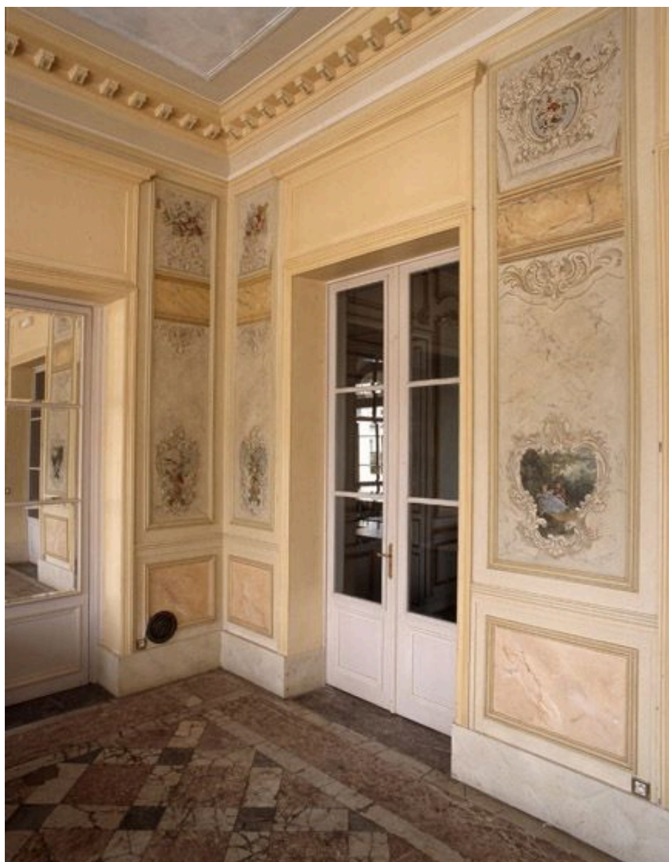
La salle des fresques (salle Laveissière) : vue partielle (angle sud-ouest). Les fresques qui datent de la fin du XIXe siècle ont été restaurées au début des années 2000.
