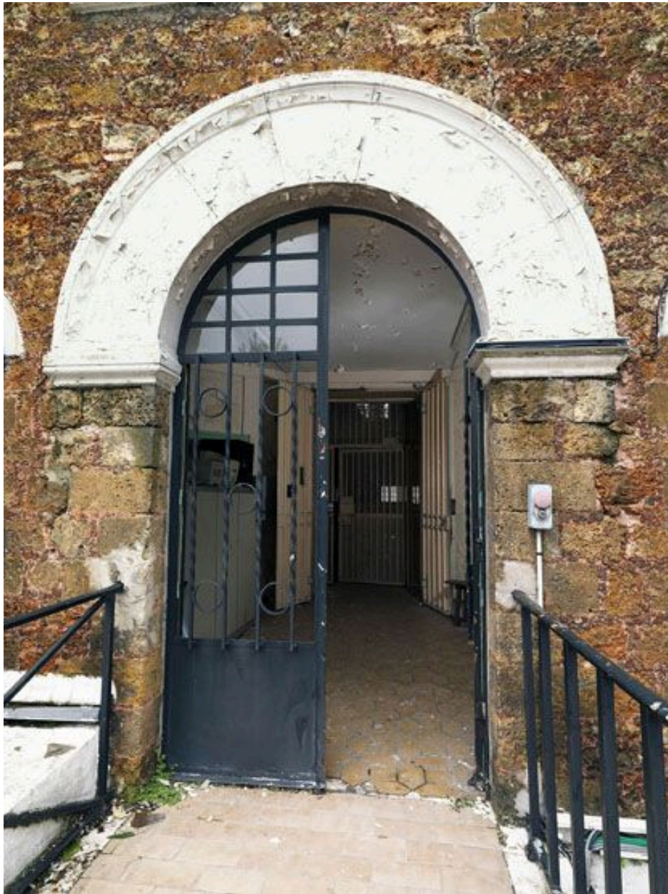
La façade de la maison d'arrêt : détail de la porte d'entrée.
