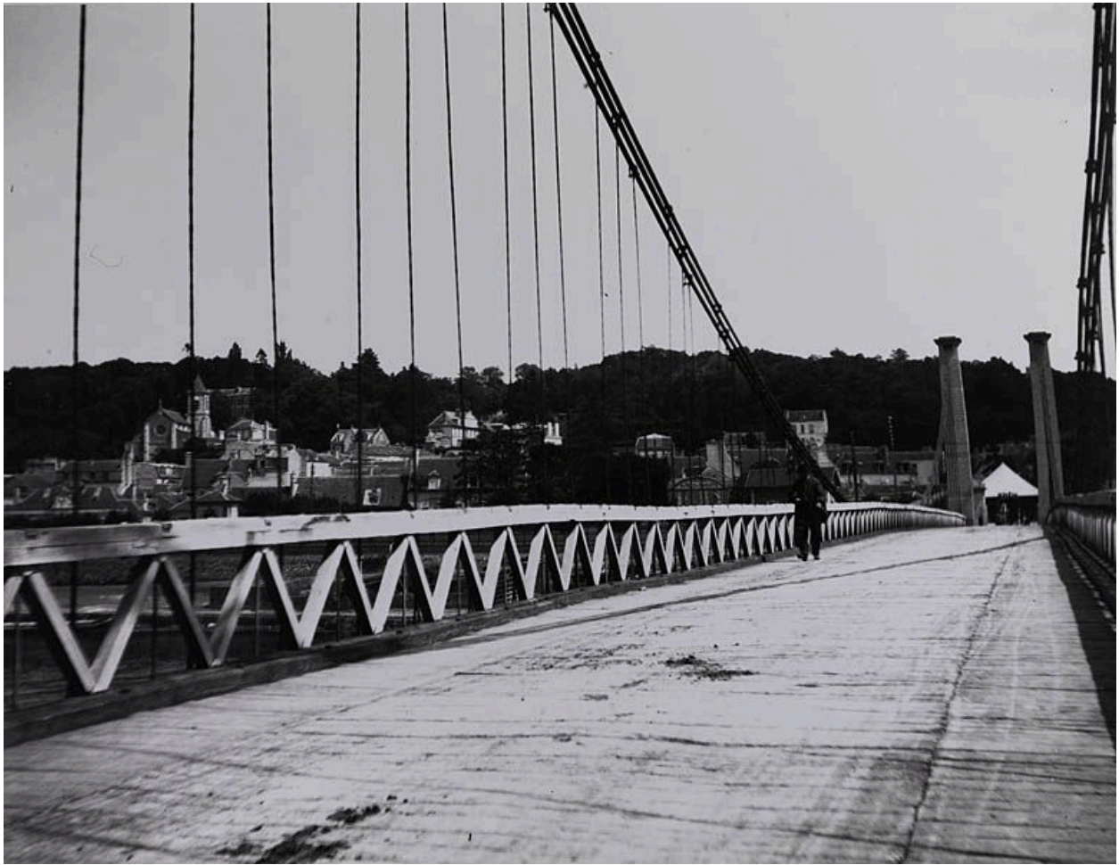
Pont suspendu de Villeneuve-Saint-Georges (n°1). Vue sur le pont suspendu. (Musée municipal, Brunoy)
