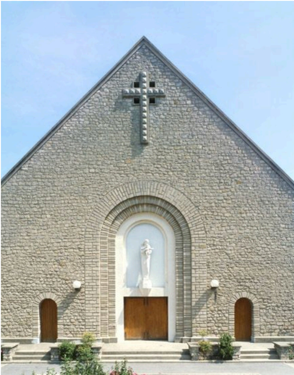
Eglise paroissiale Sainte-Marie Libératrice du Plant, 25 rue Maurice Piroley. Paul Bezault (architecte). Vue de la façade principale.
