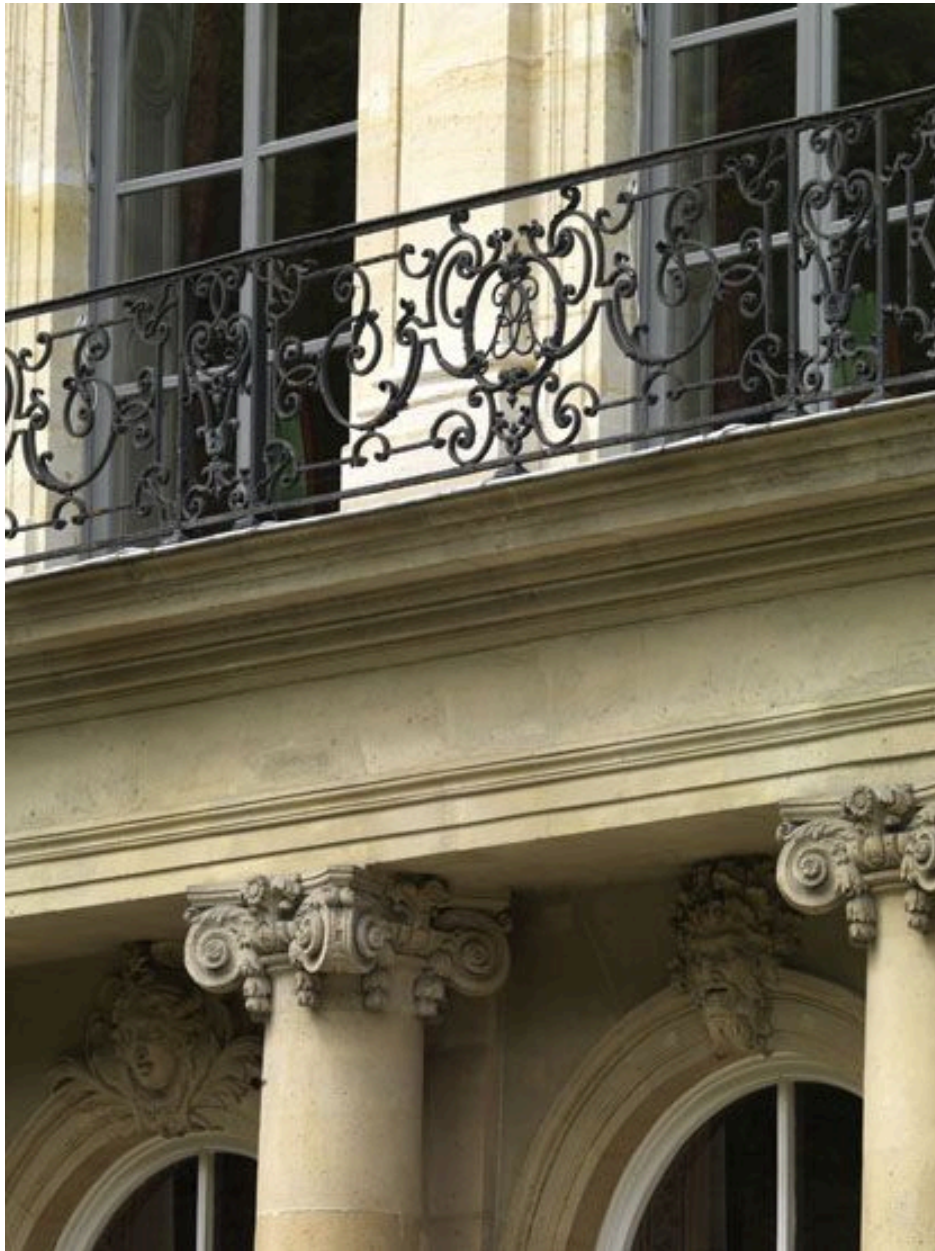
Partie centrale du balcon de l'avant corps de la façade sur jardin, hôtel de Rothelin Charolais, 101, rue de Grenelle
