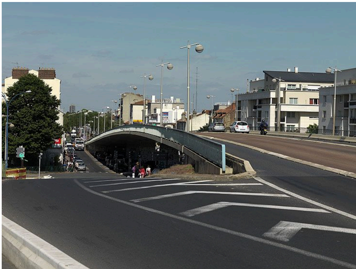
Choisy-le-Roi. Pont de Choisy (n°2). Vue, rive droite, du débouché du pont et son raccord avec la nationale en contrebas.
