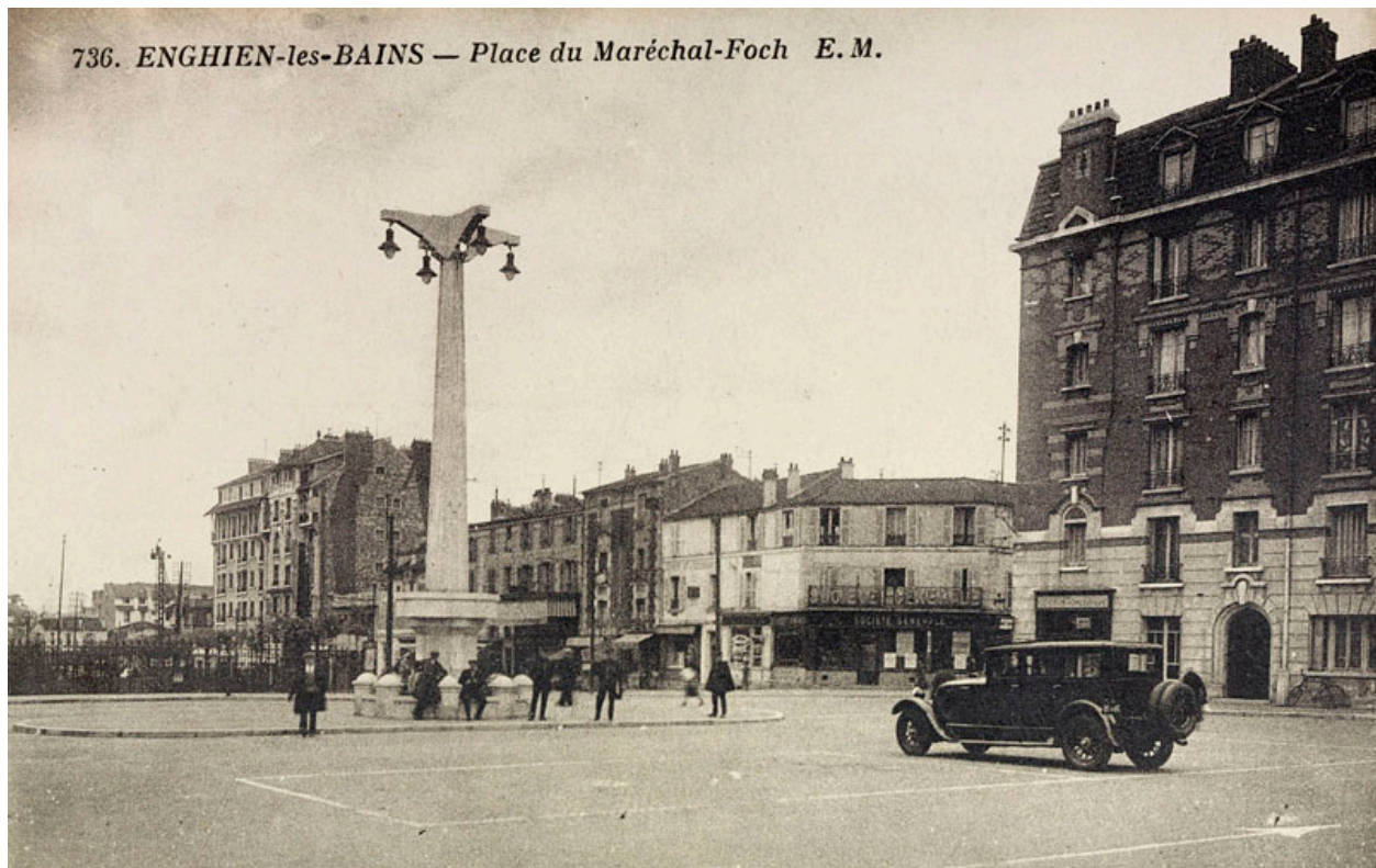
Place du maréchal Foch avec, au centre, un monument servant en réalité de cheminée d'aération. Carte postale, 1er quart 20e siècle.
