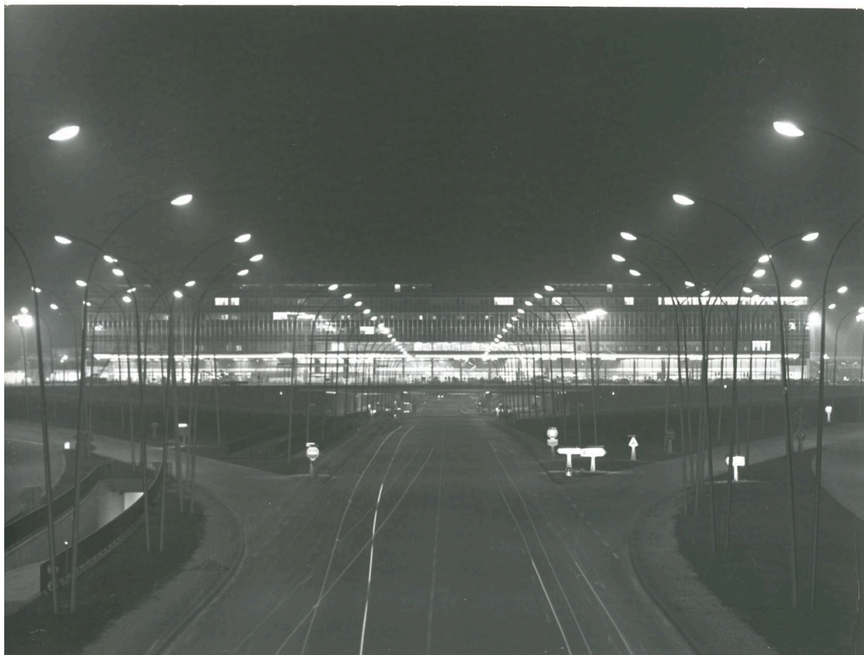
1961 1966, Les Installations terminales vues depuis le nord.
