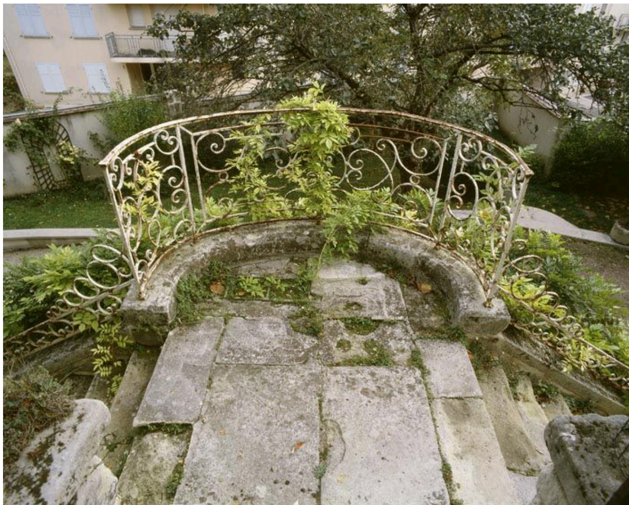
Le belvédère, vue du garde-corps.
