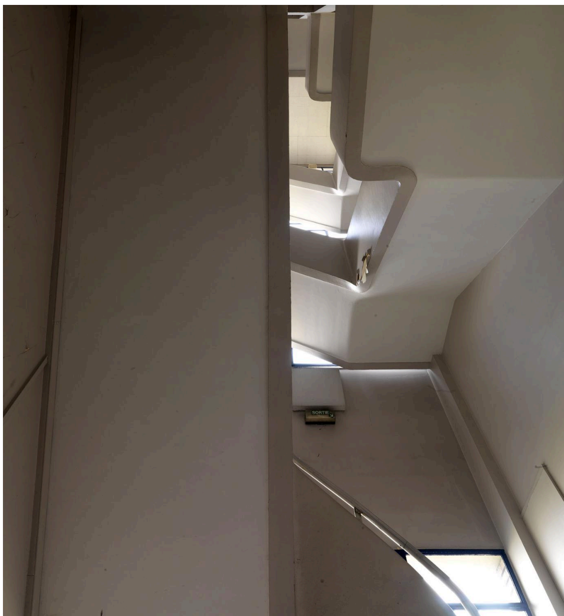
Site Sanofi. Escalier du bâtiment Nocard.
