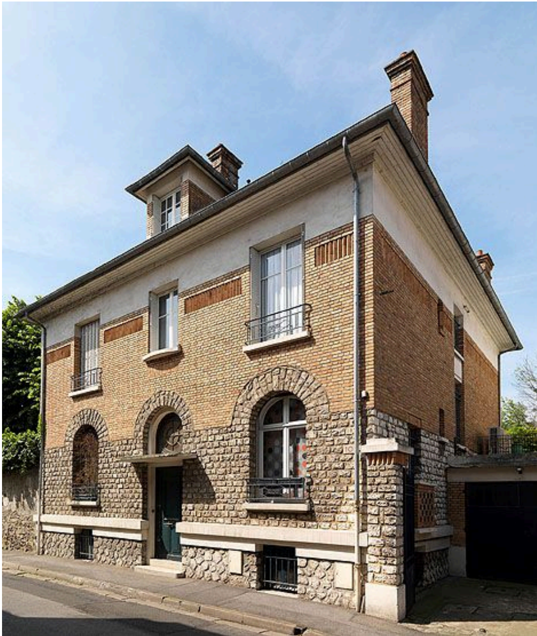
94, Choisy-le-Roi, maison, 10 rue Ledru-Rollin. Façade montrant la hiérarchie des matériaux en fonction de leur appareillage et de leur répartition.
