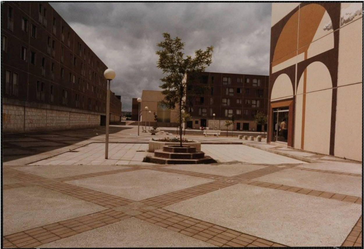
La Noé. Vue de la place des Arcades. A l'extrême droite, le bâtiment plot qui comprenait un mur pignon orné d'un motif d'arcades est aujourd'hui détruit. Photographie, vers 1978. (Cité de l'architecture et du patrimoine, Archives d'architecture du XXe siècle).
