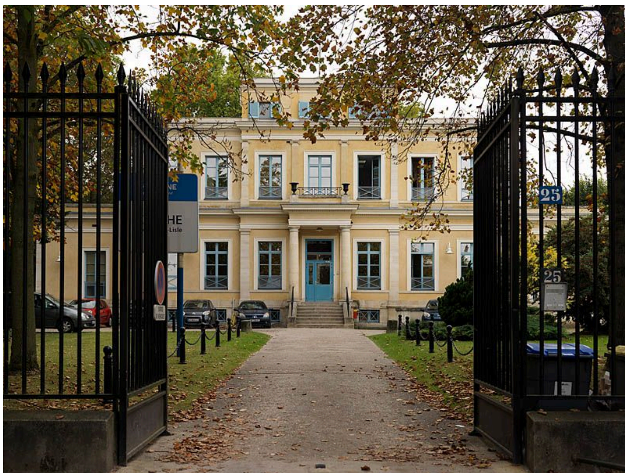
Choisy-le-Roi, maison de maître, 23 boulevard des Alliés. Vue de l'élévation antérieure.
