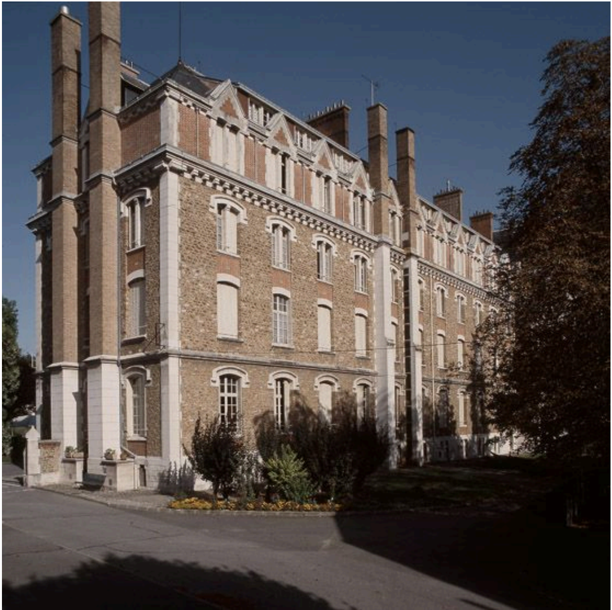
Façades antérieure et latérale du bâtiment de la communauté ou pavillon Saint-Michel.
