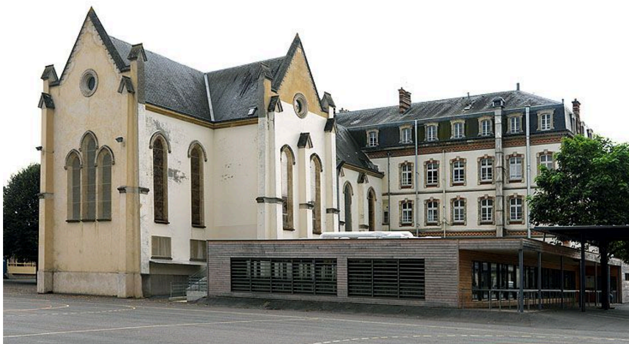
Le corps de bâtiment principal (1887) et la chapelle, vus du nord-ouest.
