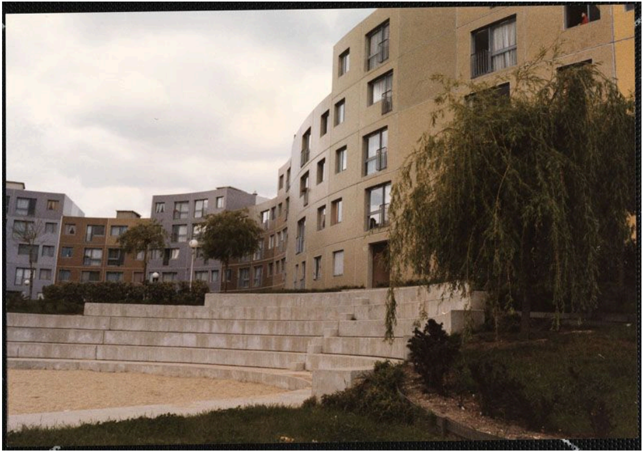
La Noé. Vue d'une partie de l'Ellipse. Photographie, vers 1978. (Cité de l'architecture et du patrimoine, Archives d'architecture du XXe siècle).
