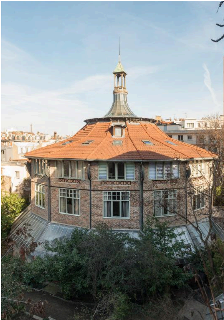
Vue générale de la Rotonde, de haut
