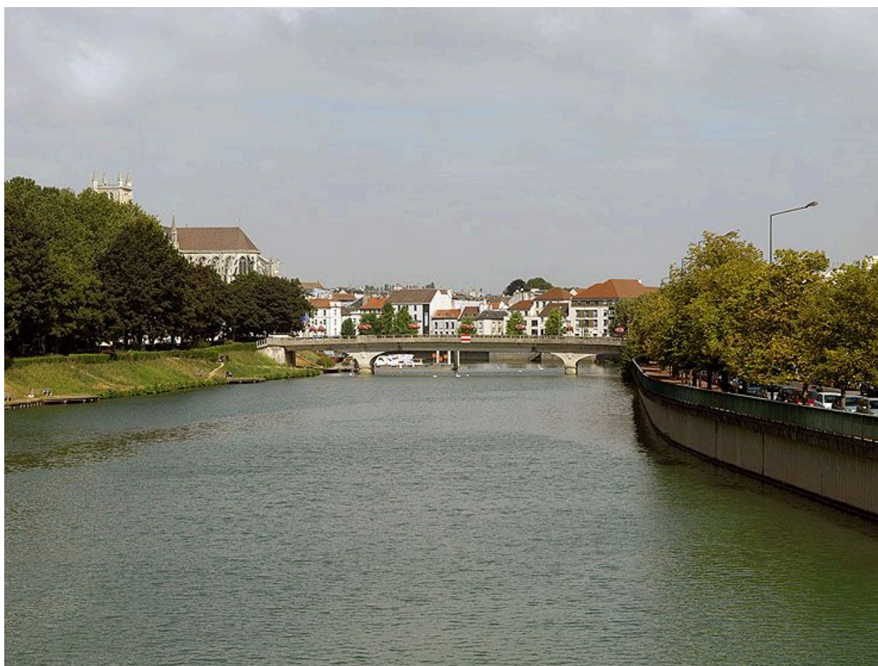
La Marne et le Pont Neuf, vus depuis le pont Foch.
