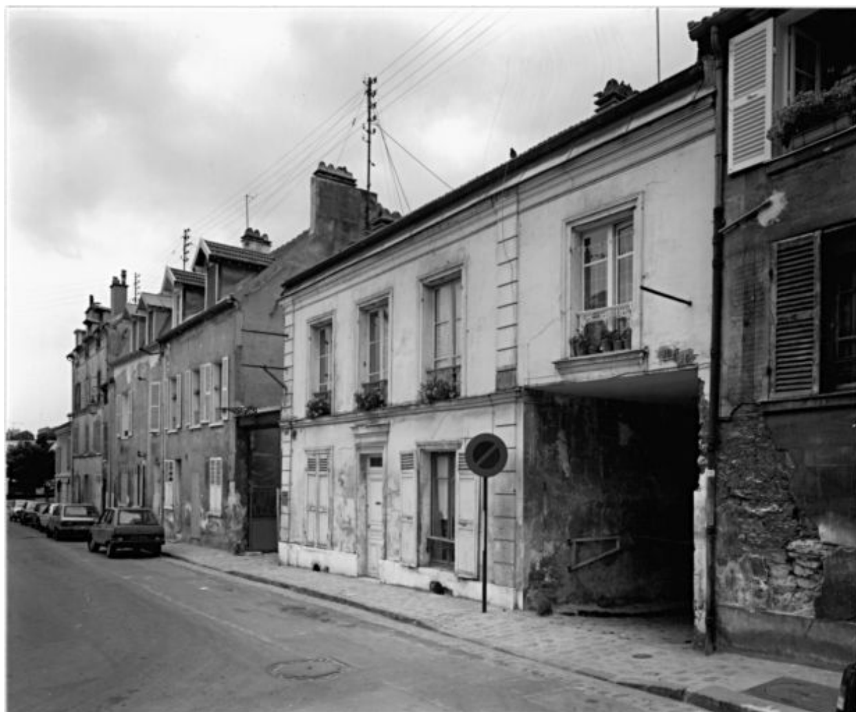
Vue de la rue et de l'entrée de la cour Saint-Vincent, rue de l'Eglise.
