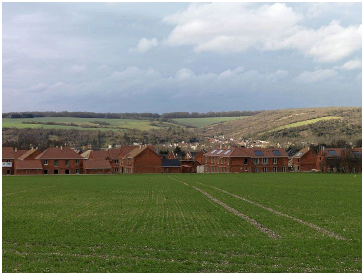
Freneuse : lotissement en construction.
