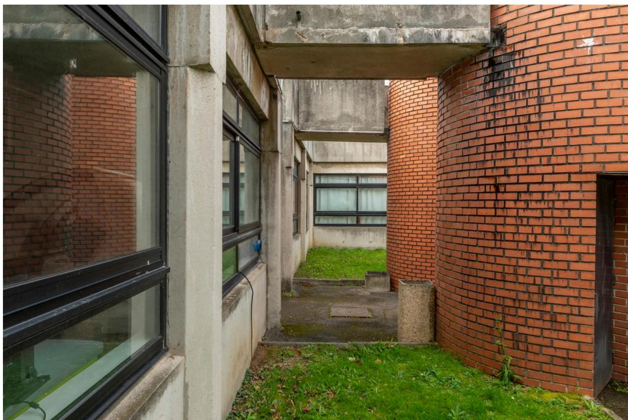
La structure est en béton armé, ainsi que les éléments de modénature, apparents. Les jeux de contrastes avec la brique rouge sont récurrents.
