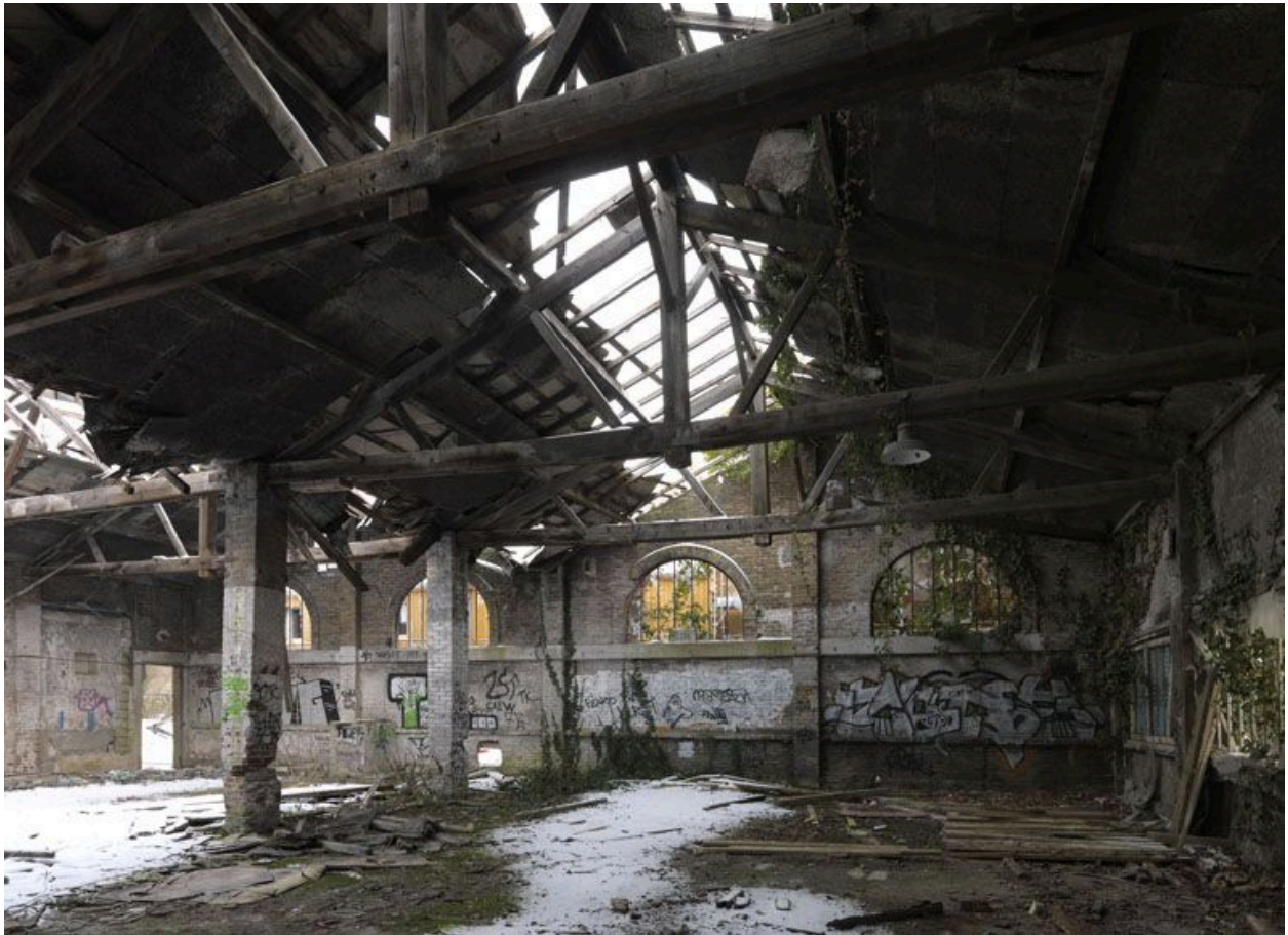
Follainville-Dennemont, cimenterie E. Candlot et Cie, puis A. Ladvocat et Cie, 44 rue Emile-Zola et rue Voltaire. Vestiges d'un atelier de préparation des matières premières.
