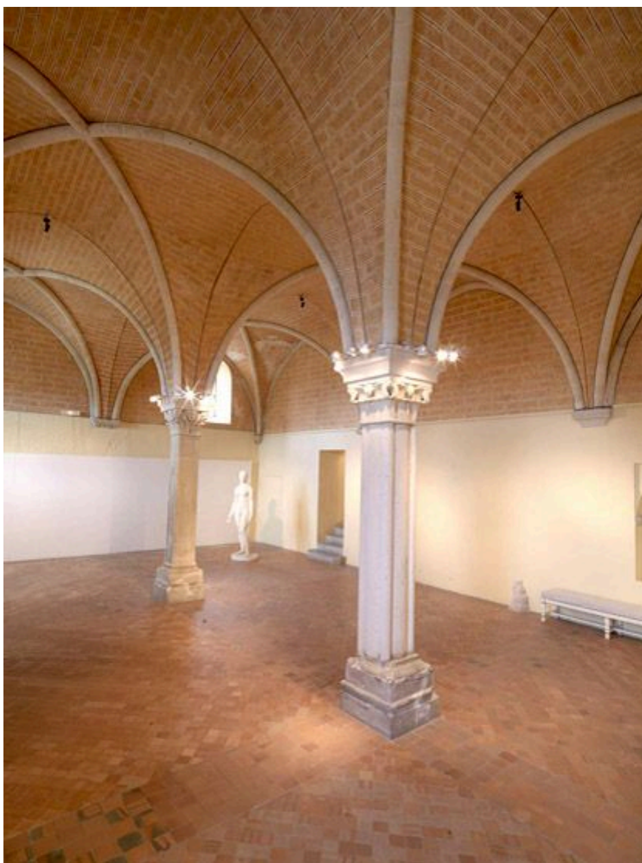
La salle basse orientale : vue d'ensemble (verticale), depuis le nord-ouest.
