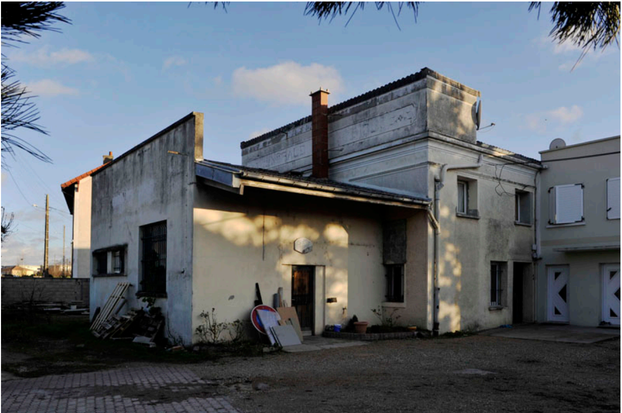
Carrières-sous-Poissy, transformateur (sous-station électrique), actuellement logement, 933 avenue Vanderbilt. Vue générale.
