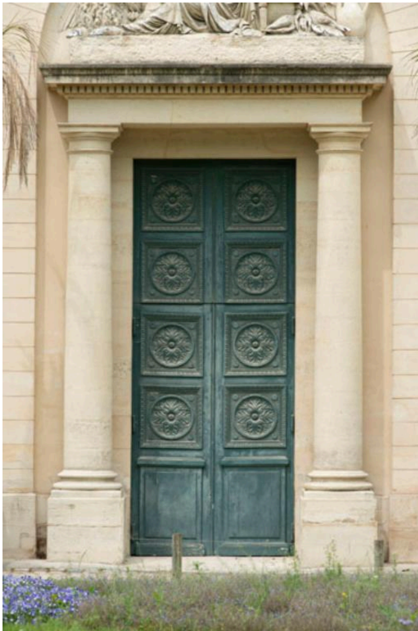
Elévation antérieure, avant-corps, détail de la porte d'entrée.
