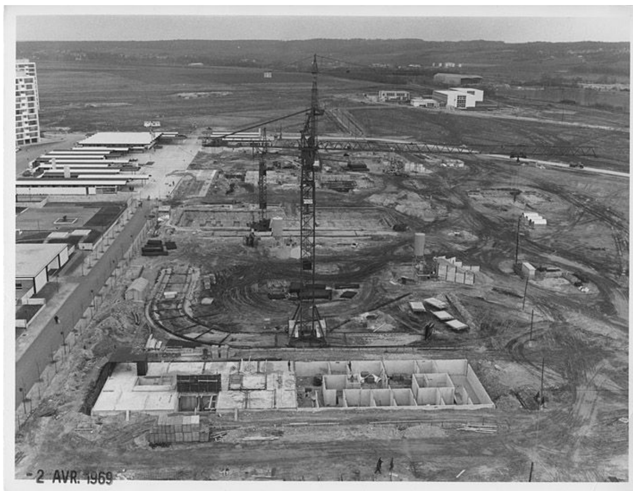
Chantier de la construction - Mise en place des grues et début de l'élévation de deux barres de Beauval. 2 avril 1969. (OPAC Meaux)
