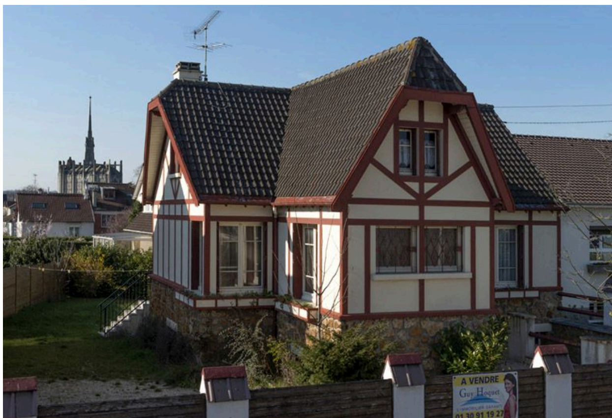
Maison 10 ter boulevard de la République. Pavillon de type néonormand construit en 1933. Architecte : Roger Garnier
