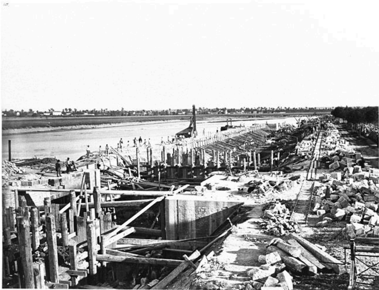
BARRAGE DE PORT À L'ANGLAIS.
