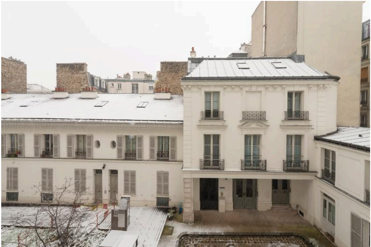
Vue de la façade du bâtiment sur cour abritant le grand escalier doubl, prise depuis le premier étage du bâtiment côté rue Hégésippe Moreau
