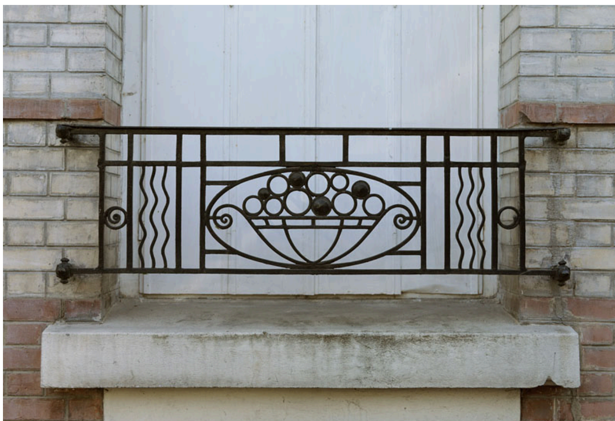
Détail de l'un des garde corps d'une baie au rez-de-chaussée.
