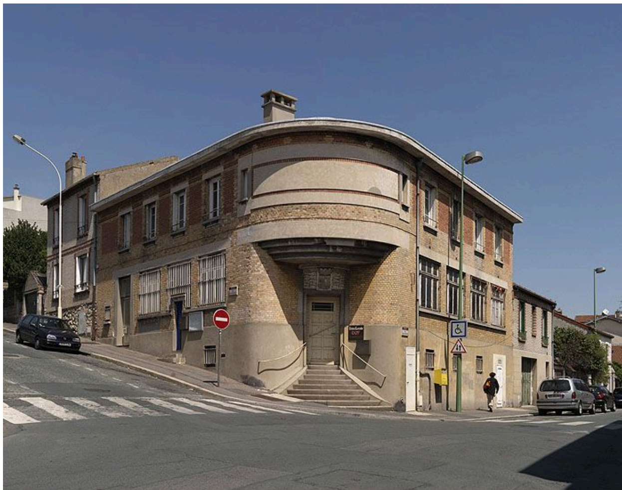
94, Arcueil, poste, 2 rue Pierre-Brossolette. Elévation et appareil de la façade sur l'arrondi de l'angle.
