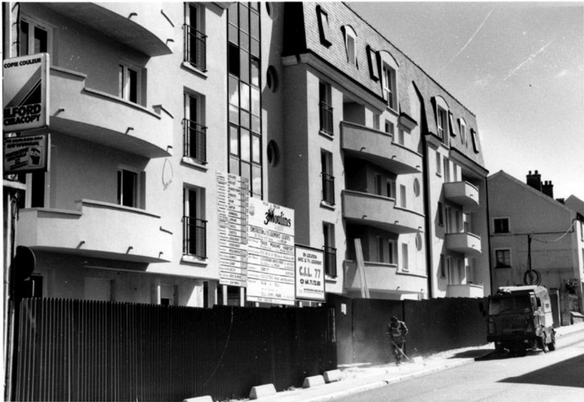
Le nouvel immeuble de la société Trois-Moulins Habitat, construit à l'emplacement d'une ferme et de maisons, 23-29bis rue Saint-Liesne (cf cliché précédent, 05770317NUCB). Vue prise le 20/06/1995. (Collection particulière)
