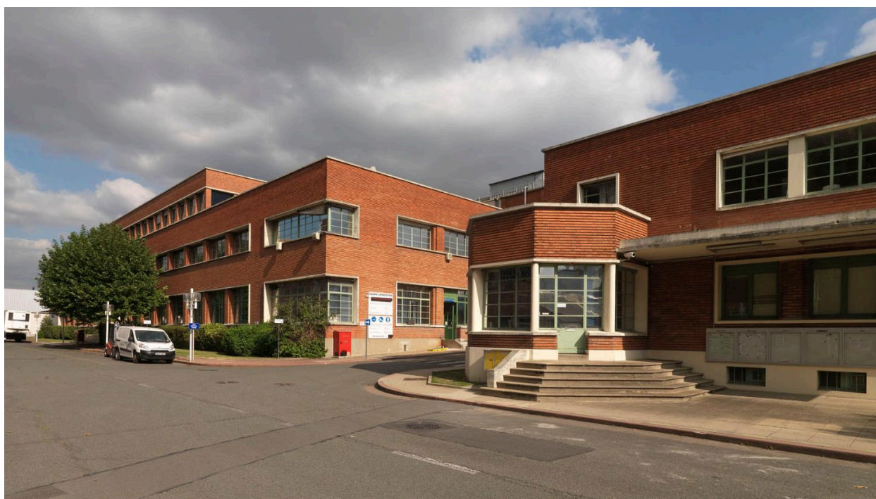
Site Sanofi. Vue du bâtiment de la direction.
