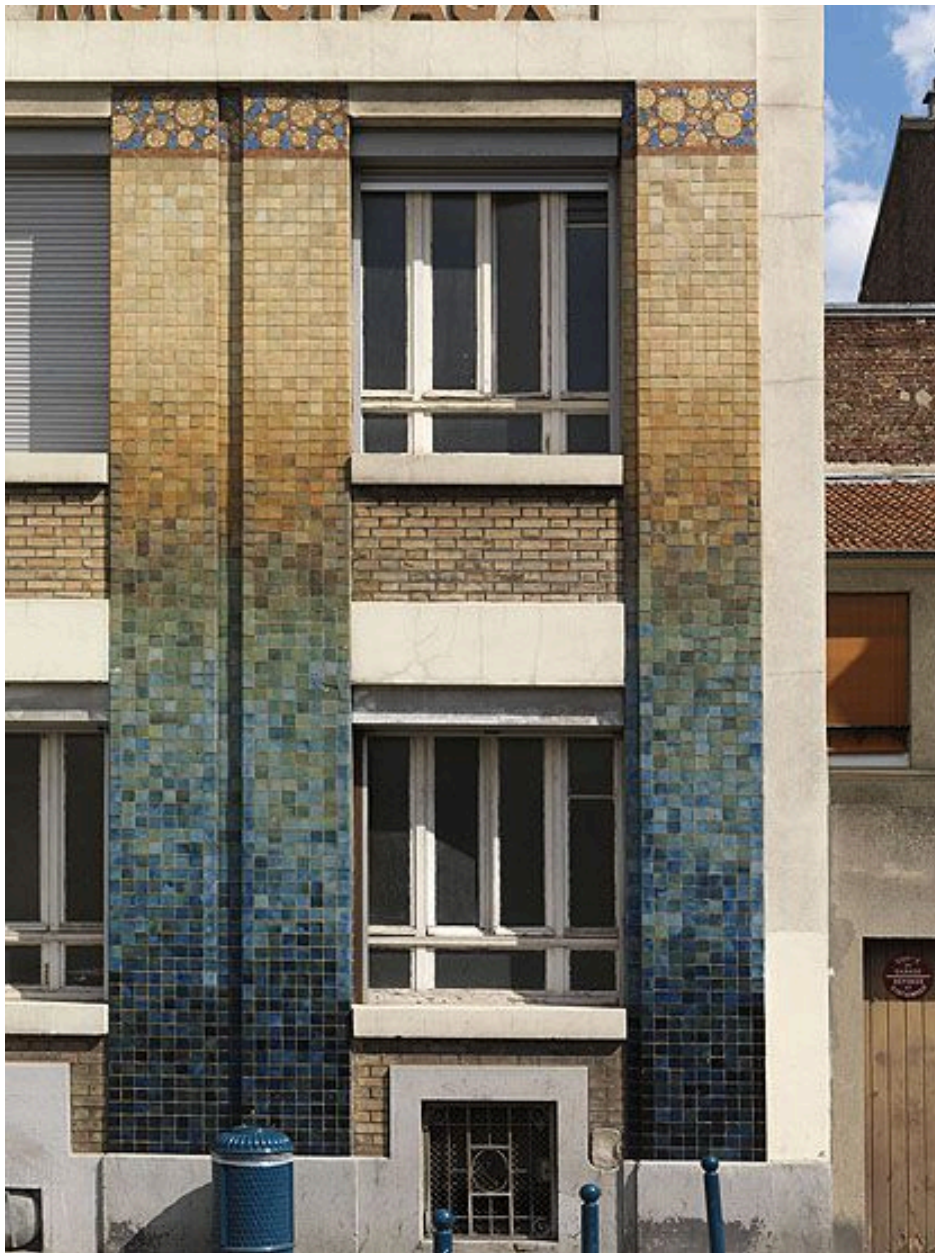
93, Pantin, crèche Berthier, rue Berthier. Détail des travées de droite de la façade de la crèche à parement de céramique polychrome.
