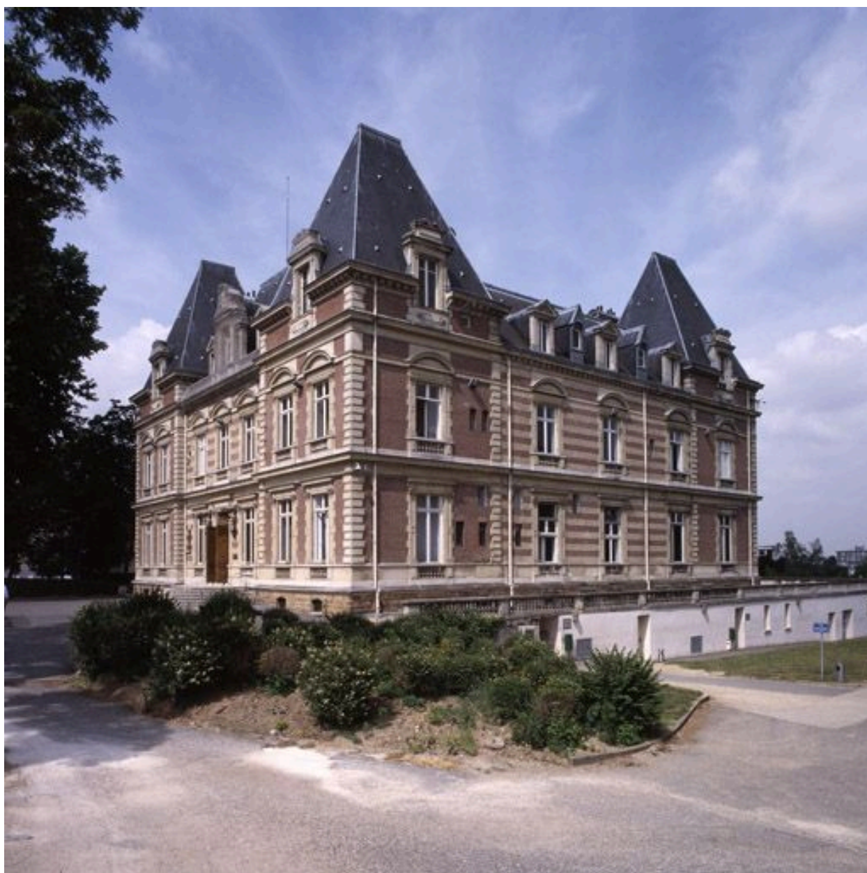
Façades antérieure et latérale est.
