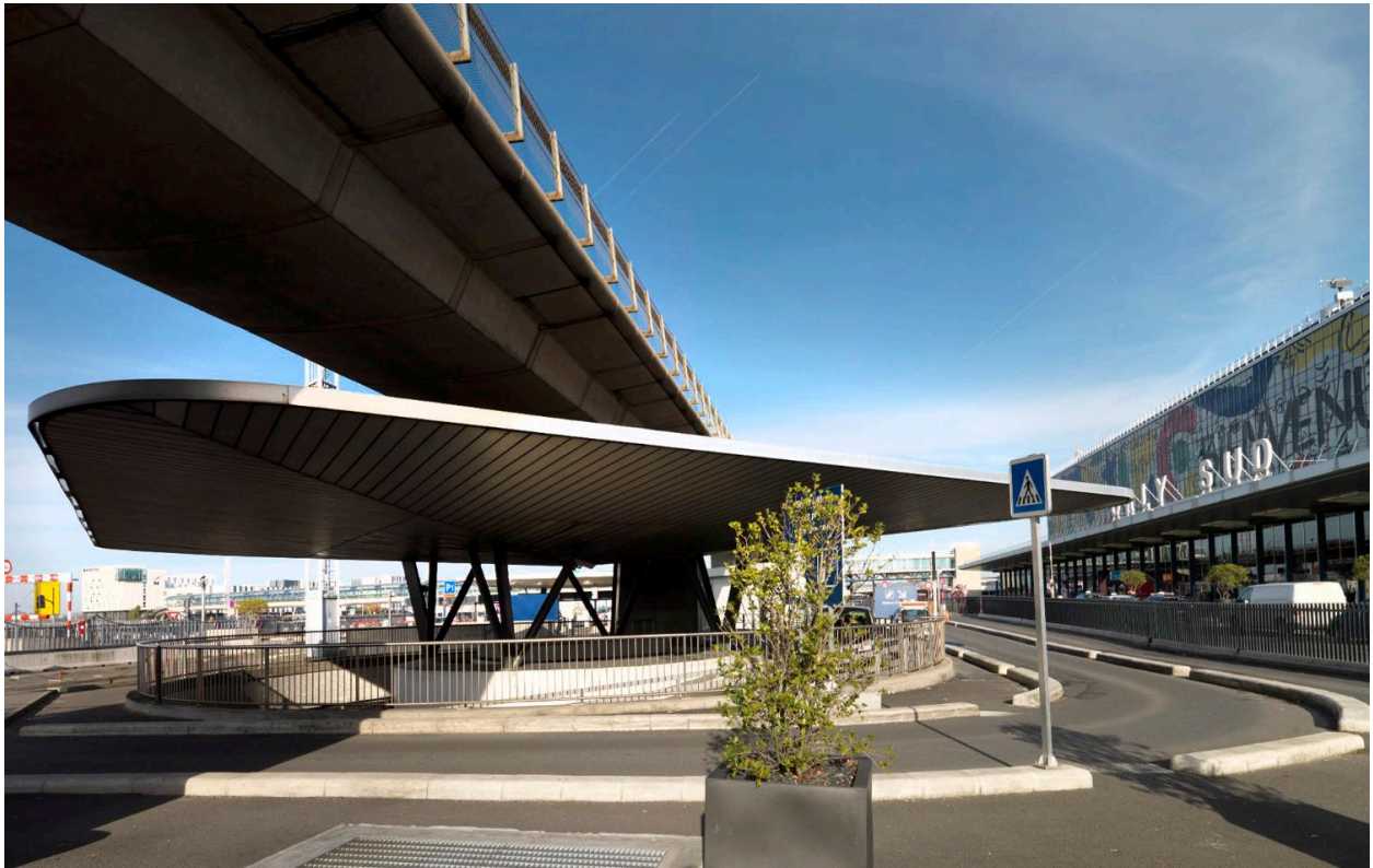
2018, entrée du parking P4a sous la la station d'Orlyval Orly-Sud, vue prise depuis l'ouest.
