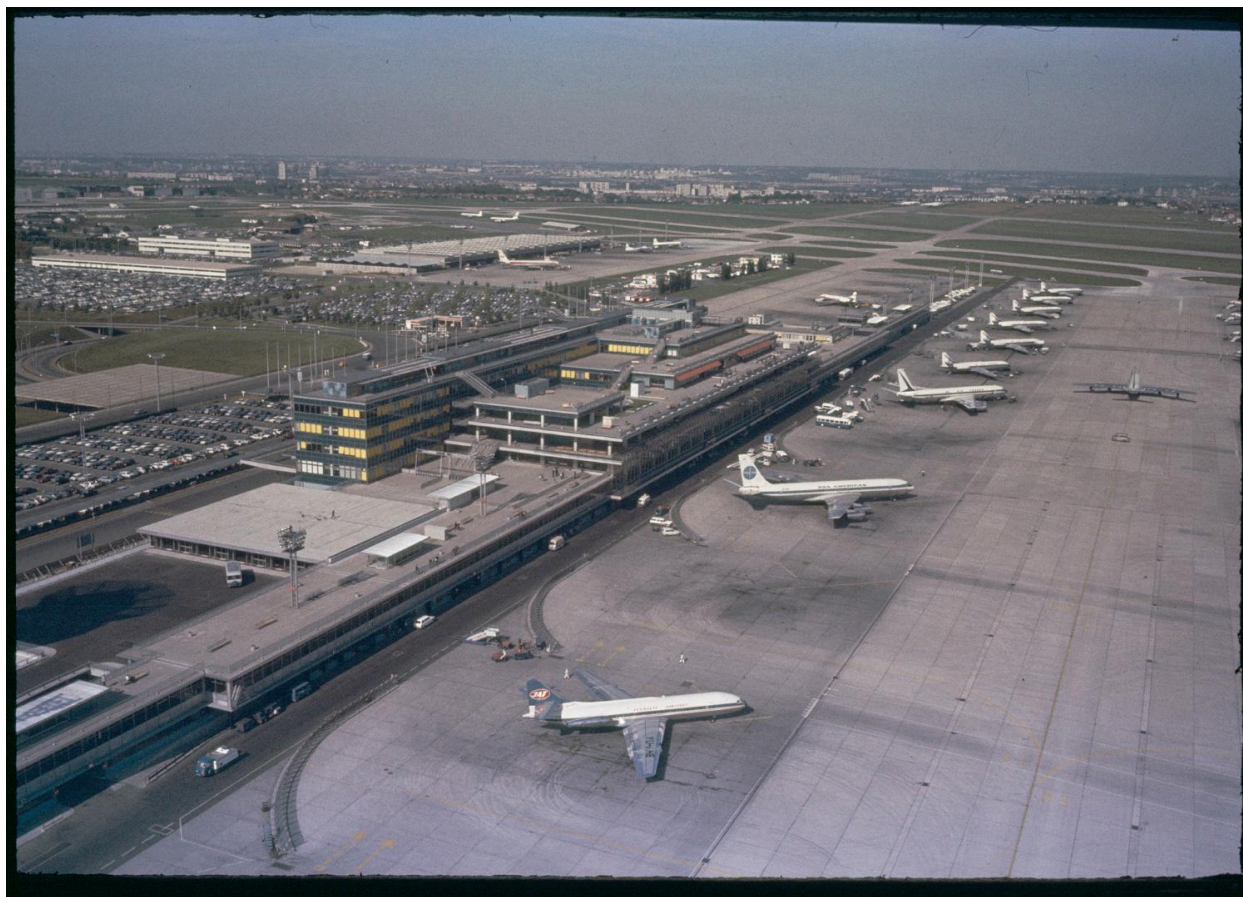
1961 1966, les Installations Terminales vues depuis l'ouest.
