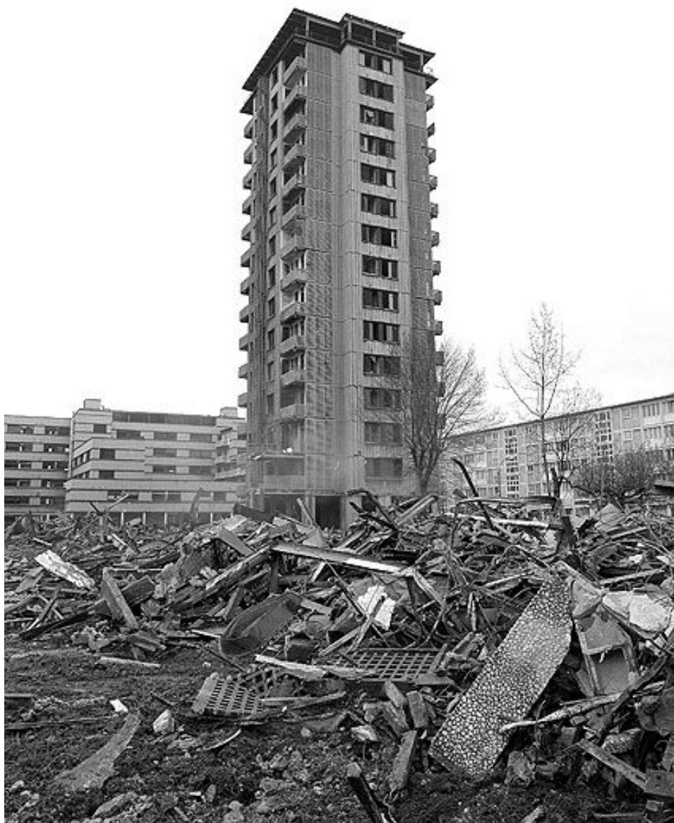
Tour 1, coin sud-est. Campagne photographique, lors de la destruction du bâtiment en 1976.
